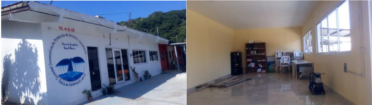
Figura 5.9: Instalaciones de la cooperativa de R.G
