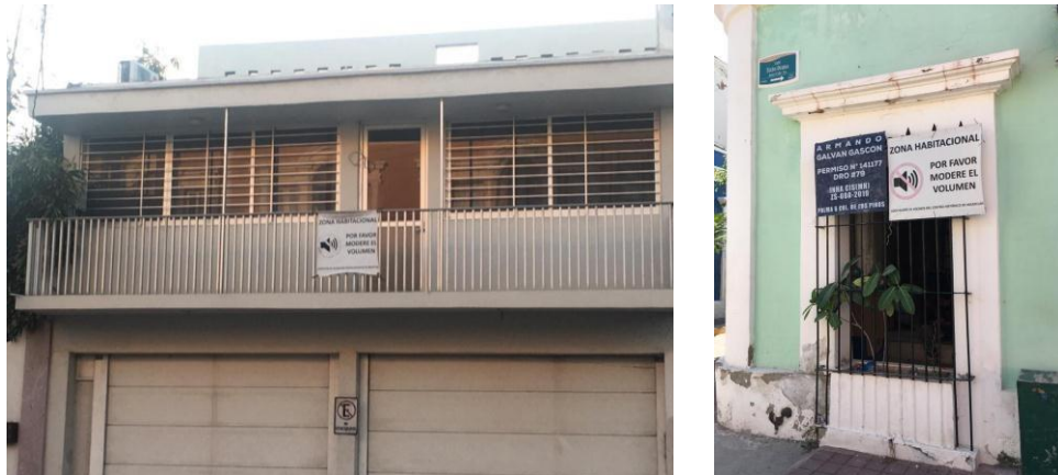
Figura 46. Manifestaciones de inconformidad en las fachadas de viviendas del CHM
