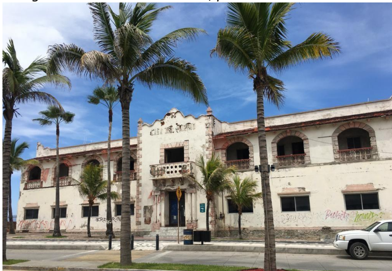
Figura 49. La Casa del Marino, patrimonio en abandono
