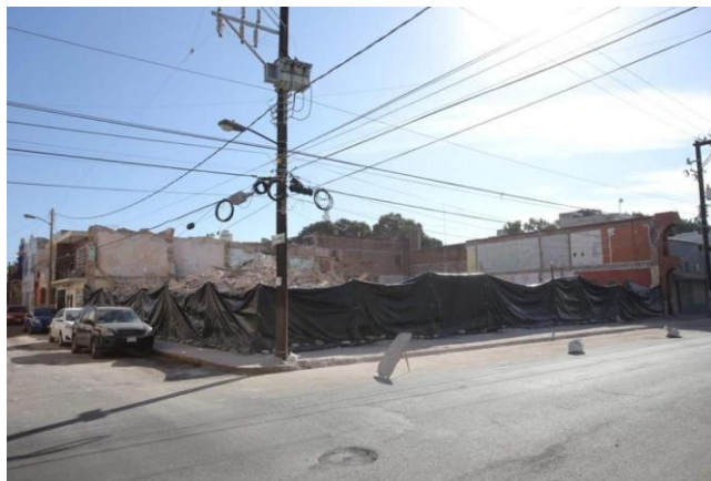
Figura 51. Demolición de casona de finales del siglo XIX en el CHM
