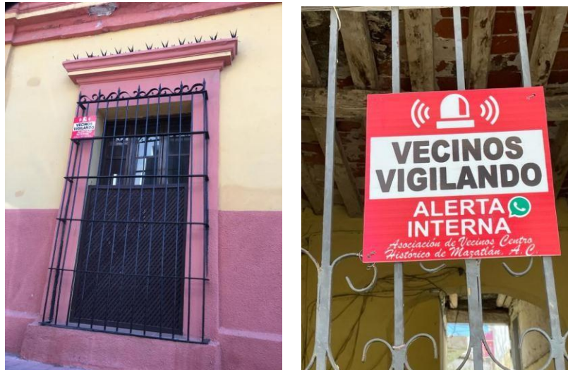
Figura 31. Señalamientos disuasivos en fachadas de casas y negocios en el CHM
