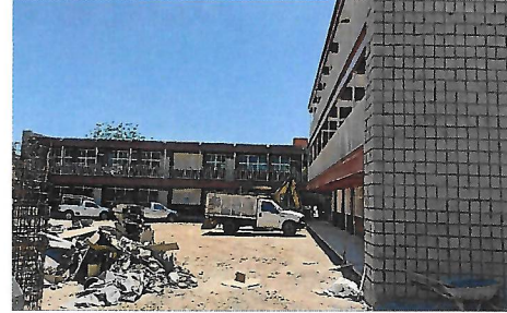
F2: Fachada posterior
