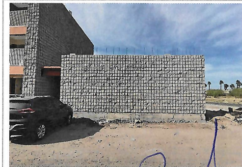
F3: Fachada lateral derecha
