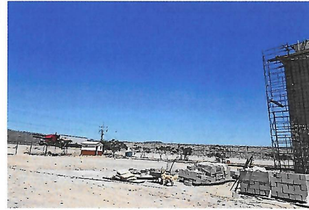
F2: Fachada posterior
