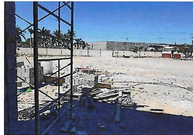
F4: Fachada lateral izquierda
