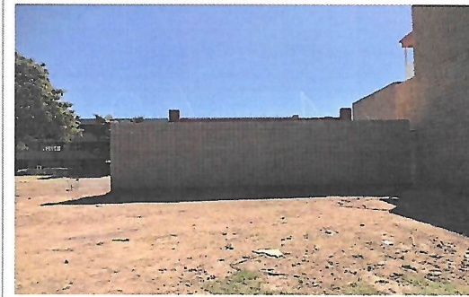
F4: Fachada lateral izquierda
