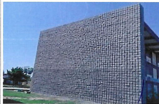
F3: Fachada lateral derecha
