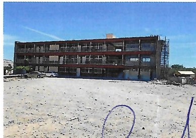
F3: Fachada lateral derecha
