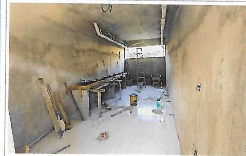
F5: Foto interior de obra.
