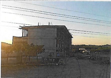
F3: Fachada lateral derecha
