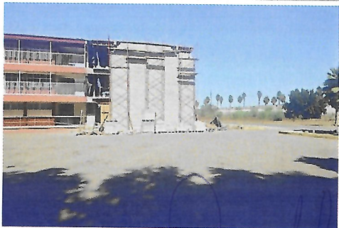
F3: Fachada lateral derecha
