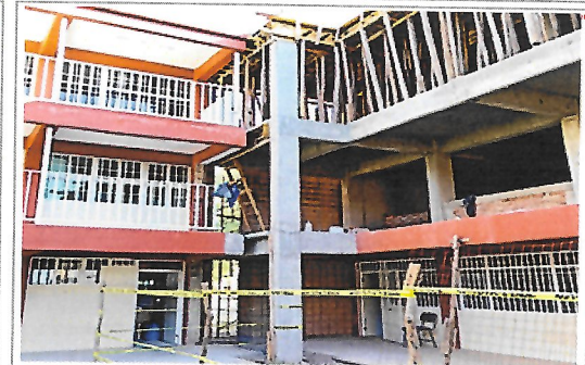
F5.- Foto puente de conexión.
