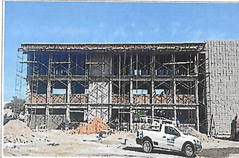
F2: Fachada posterior
