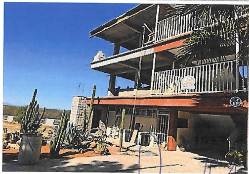
F3: Fachada lateral derecha
