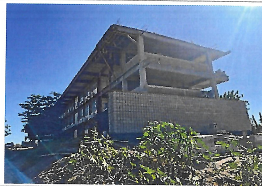
F2: Fachada posterior
