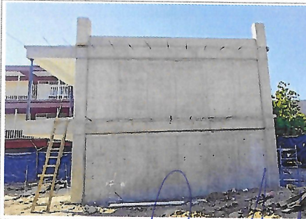
F3: Fachada lateral derecha
