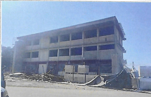
F4: Fachada lateral izquierda
