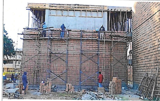
F4: Fachada lateral izquierda
