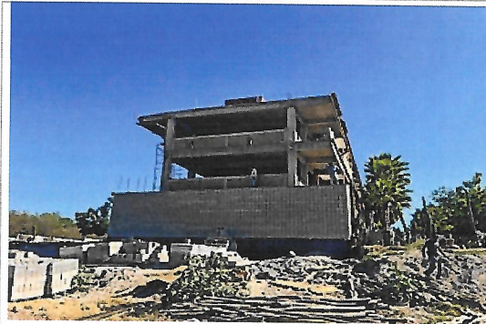
F4: Fachada lateral Izquierda
