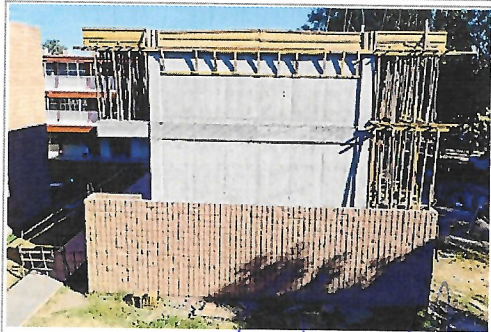
F3: Fachada lateral derecha
